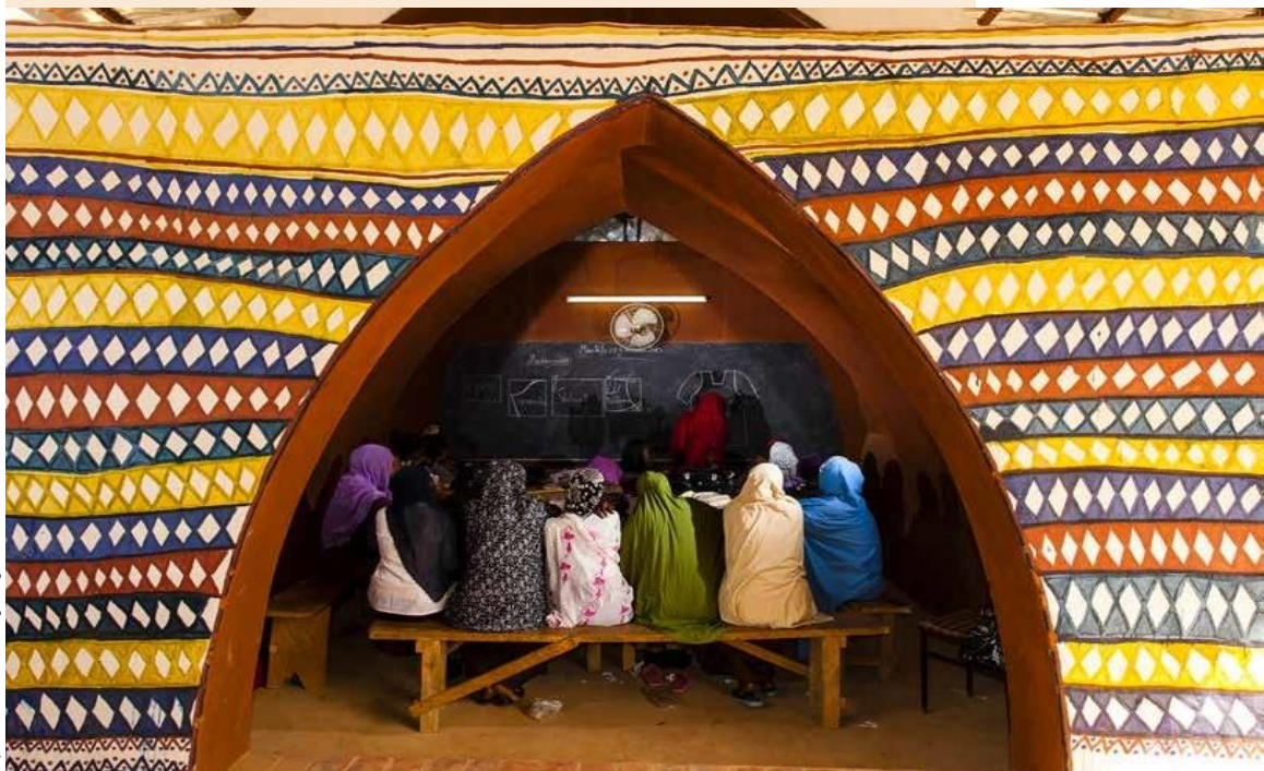
โรงเรียนสอนเย็บปัก Steel-Earth ที่เมืองโนามิ ประเทศในจอร์แดน สร้างเมื่อปี 2011 โดยการผสมผสานความรู้ ความชำนาญและวัสดุท้องถิ่นเข้ากับความก้าวหน้าของเทคโนโลยีร่วมสมัย โครงสร้างซึ่งใช้วัสดุต่าง ๆ รวมทั้งบันโก คือดินเหนียวผสมกับฟางที่ต้านความร้อนได้ดี ถูกเสริมให้มั่นคงและคงทนด้วยหลังคาโลหะสองชั้น
