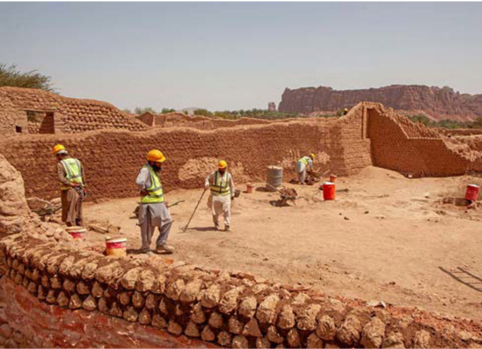
▼ ความสำเร็จก่อสร้างกำแพงพารามสมัยโบราณขึ้นใหม่ที่โอเอซิสใกล้เมืองเก่า ปี 2025
